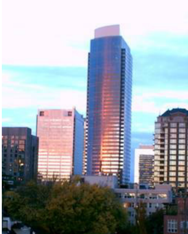
Figura 1-1 –Two Union Square, Washington, USA, (1987/1989). Altezza: 226 m; resistenza a compressione: 131 MPa
