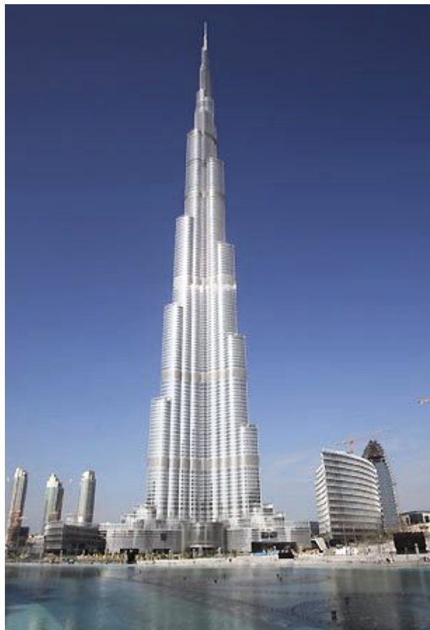
Figura 1-3 –Burj Khalifa Tower, Dubai, United Arab Emirates, (2004/2010). Altezza: 829 m; resistenza a compressione: 60 MPa; pompato fino a 600 m di altezza
